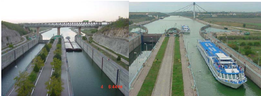
Foto: Schleuse Cernavoda
